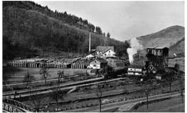
Hubacker Bahnhof und Firma Koehler ca. 1955 Foto: Ingrid Huber
