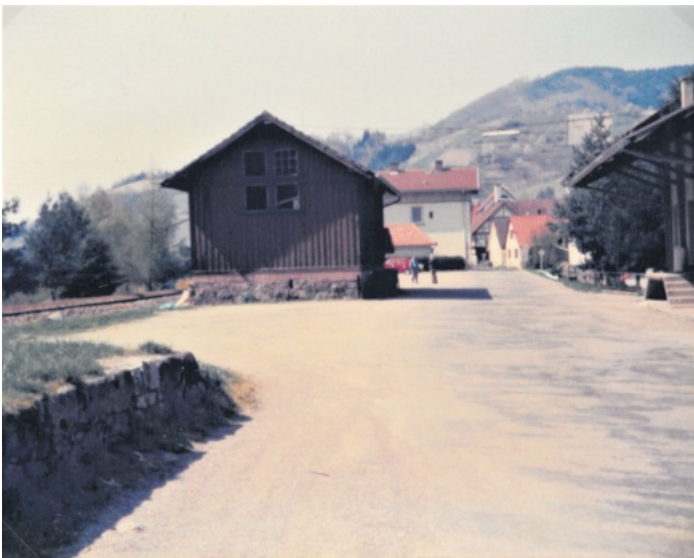
Güterhalle am Bahnhof die 1985 abgerissen wurde Foto: Ingrid Huber
