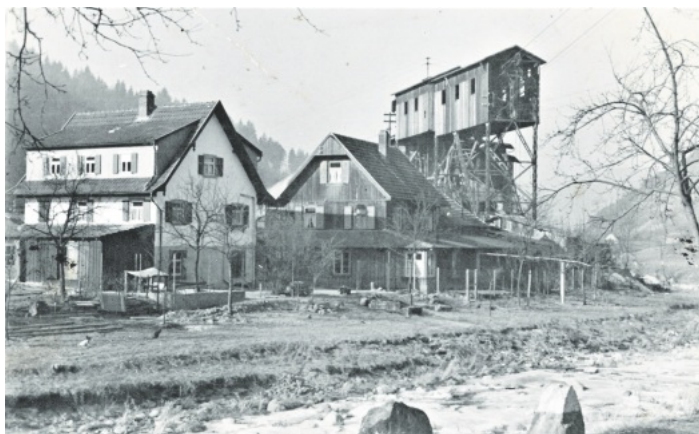
Schotterwerk Hubacker mit Seilbahn ca. 1950
