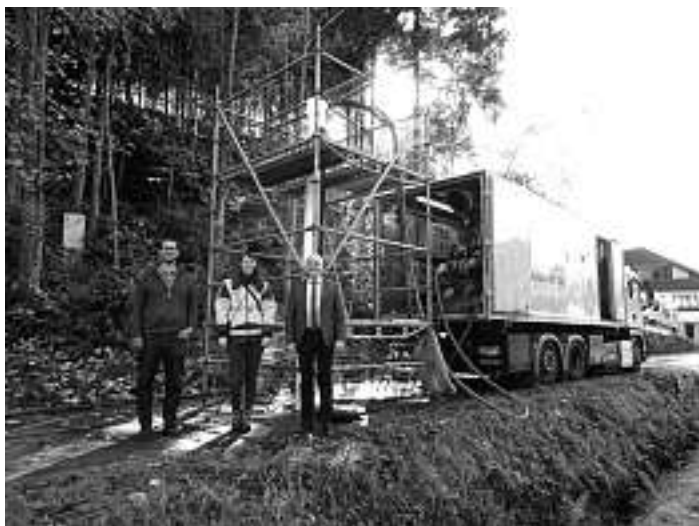
Hauptamtsleiter Bastian Knapp, Bianca Zink (VOGEL Ingenieure GmbH) und Bürgermeister Thomas Krechtler überzeugten sich vom Baufortschritt
