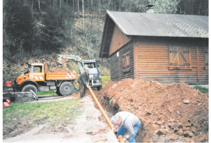
Die Steighütte wird an das öffentlich Stromnetz angeschlossen - 2001 Foto: Gemeindeverwaltung
