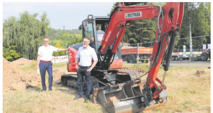
Erik Füssgen, Geschäftsführer der Renchtal Bürgerenergie, und Projektleiter Tobias Vespermann haben sich vom Baufortschritt der Freiflächenphotovoltaikanlage ein Bild gemacht. Foto: Renchtal Bürgerenergie
