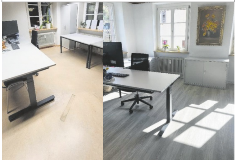
Büroräume vor / nach der Sanierung
