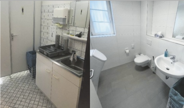
Sanitäranlagen vor / nach der Sanierung
