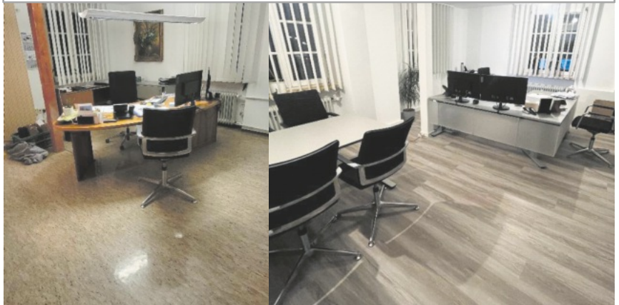
Büroräume vor / nach der Sanierung
