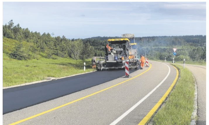
Fahrbahndeckenerneuerung auf der B500 Foto: RPK
